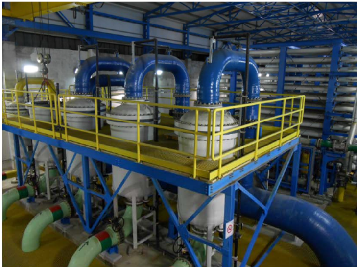
FIGURA 11. INSTALACIÓN DE MICROFILTROS EN UNA PLANTA DESALINIZADORA
